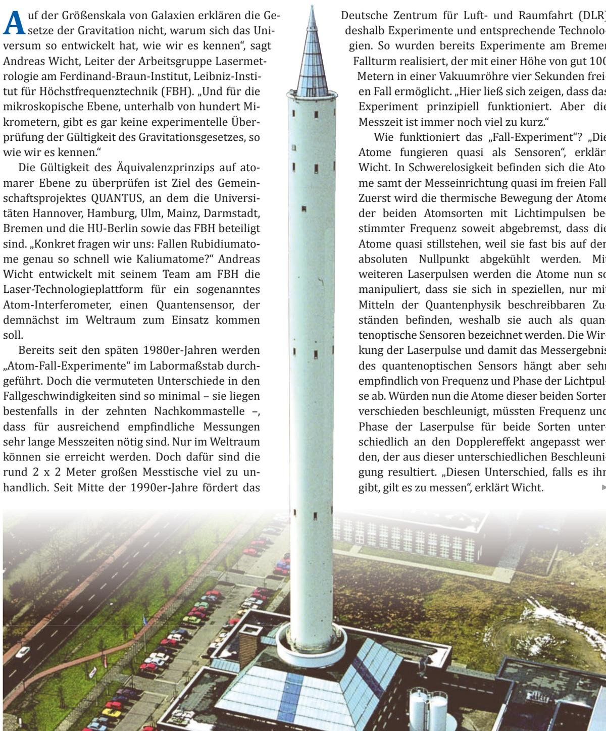
Im Bremer Fallturm lassen sich Experimente in Schwerelosigkeit realisieren – allerdings nur 4 Sekunden lang.
